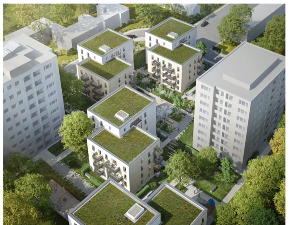
Die vier neuen Gebäude der buchdrucker und der Hamburger Lehrer-Baugenossenschaft erhalten eine Dachbegrünung zur Verbesserung des Stadtklimas. Außerdem werden Photovoltaikanlagen installiert, die auf der Visualisierung noch nicht berücksichtigt sind.
