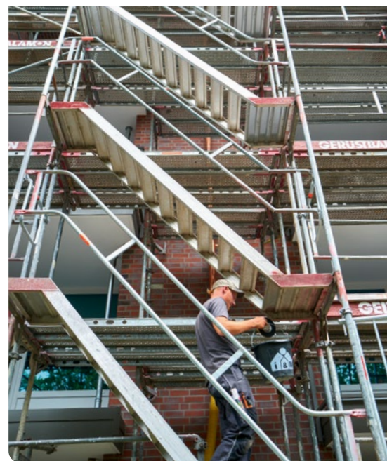
Im Juni 2023 waren die Bauarbeiten in der Langenhorner Chaussee noch in vollem Gang. Die Balkonsanierung war bereits abgeschlossen und die Montage der neuen Balkongeländer sollte als Nächstes erfolgen.
