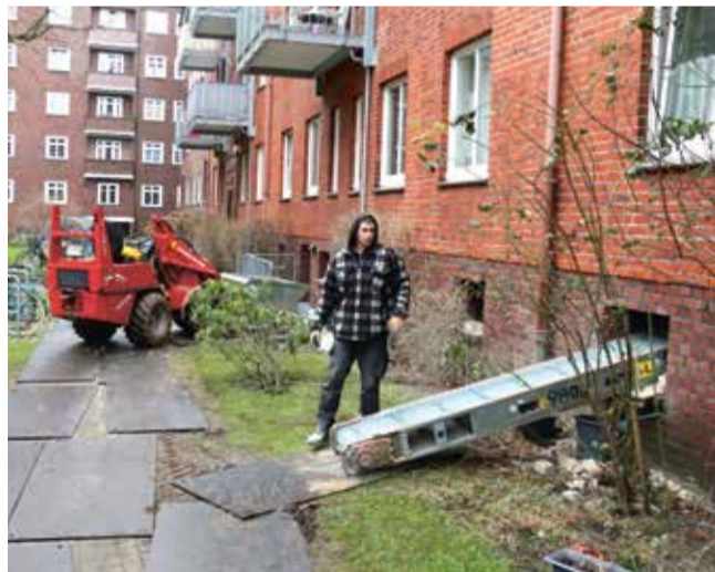
Umfassende Keller-sanierung im Braußpark: Die Böden wurden neu gegossen, die Mieterkeller erhielten neue Trennwände und wurden elektrifiziert.
