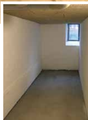
Umfassende Keller-sanierung im Braußpark: Die Böden wurden neu gegossen, die Mieterkeller erhielten neue Trennwände und wurden elektrifiziert.
