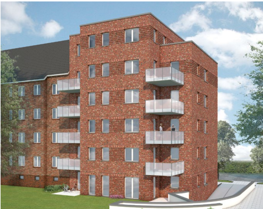
Das neue Wohnhaus im Braußpark schließt sich unmittelbar an ein Bestandsgebäude der buchdrucker an. Eine Tiefgarage ist bereits vorhanden und wird in den Neubau integriert.
