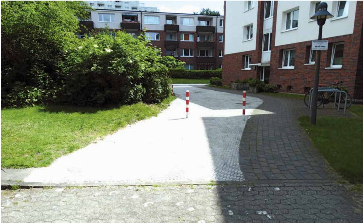
Feuerwehrezufahrt zwischen den Häusern Düpheid 16 und 18
