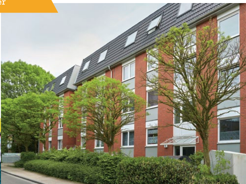
Dachdämmung und neue Fenster
